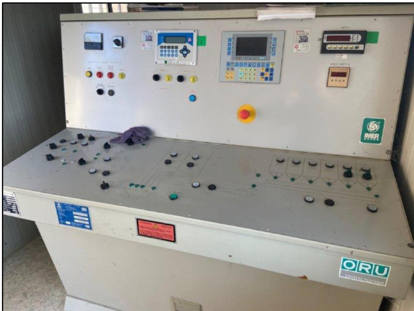
Foto 8 - Quadro di comando impianto cls
