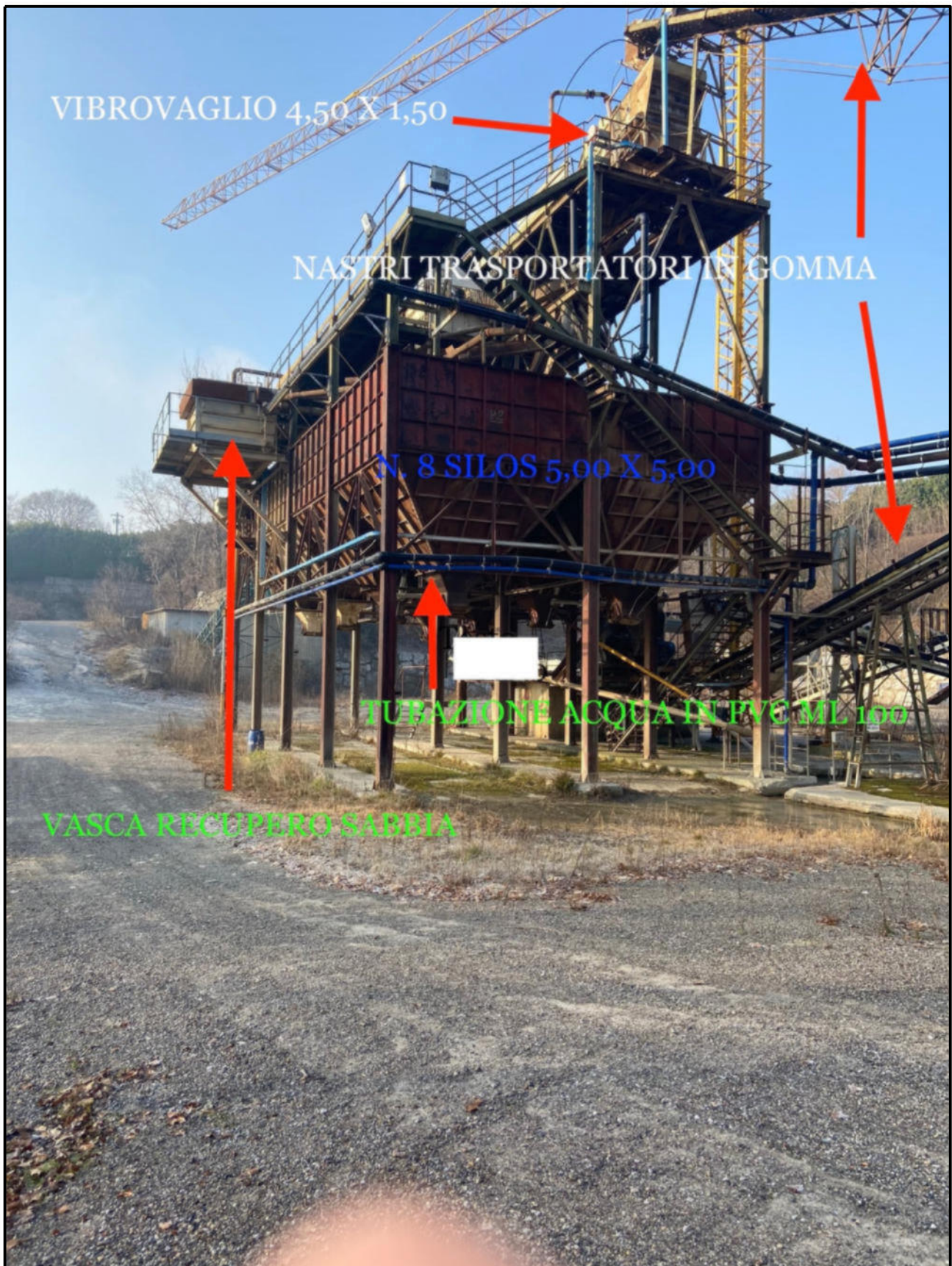
Foto 3 - Impianto produzione aggregati vista nord
