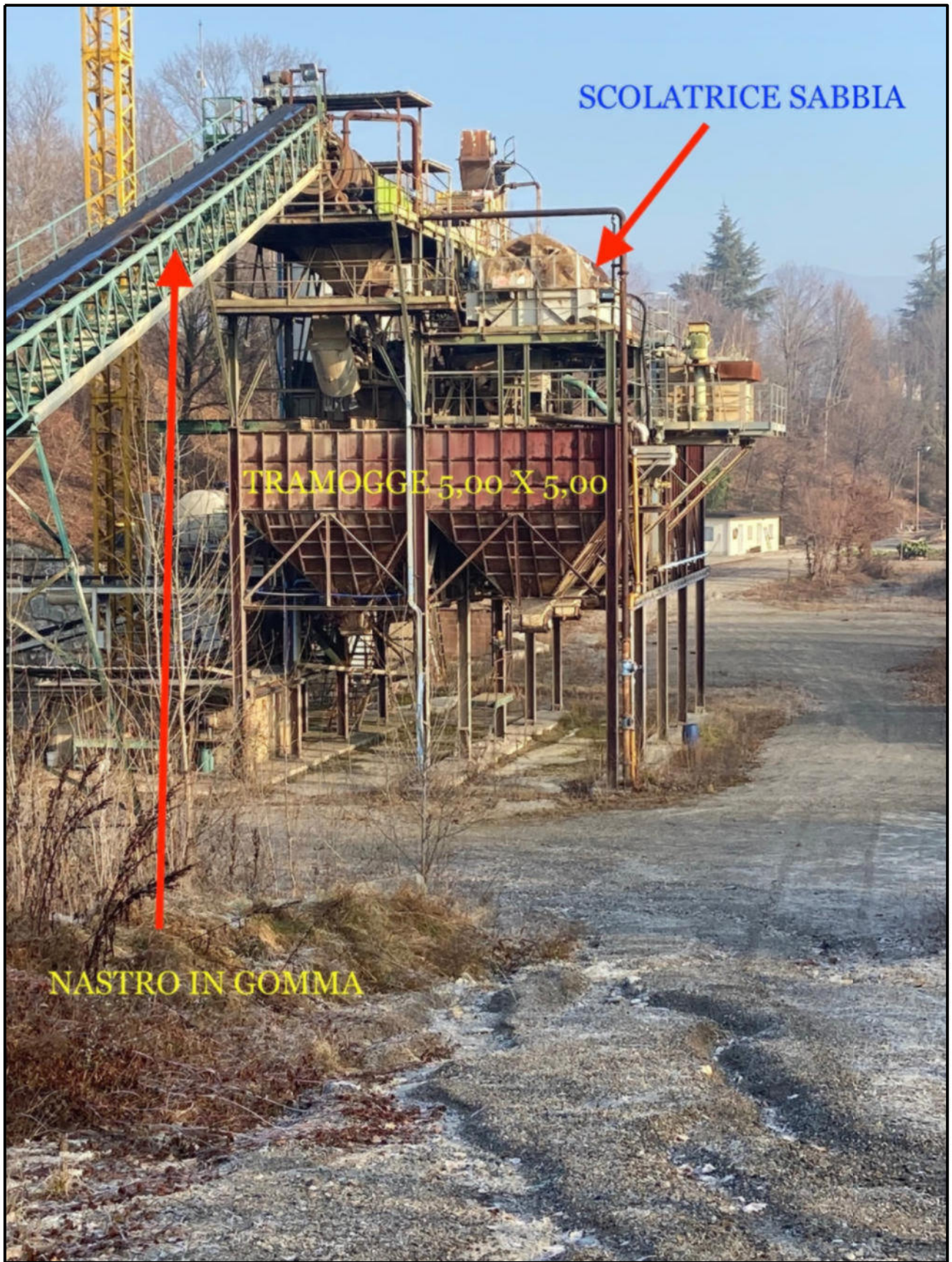
Foto 2 - Impianto produzione aggregati vista sud
