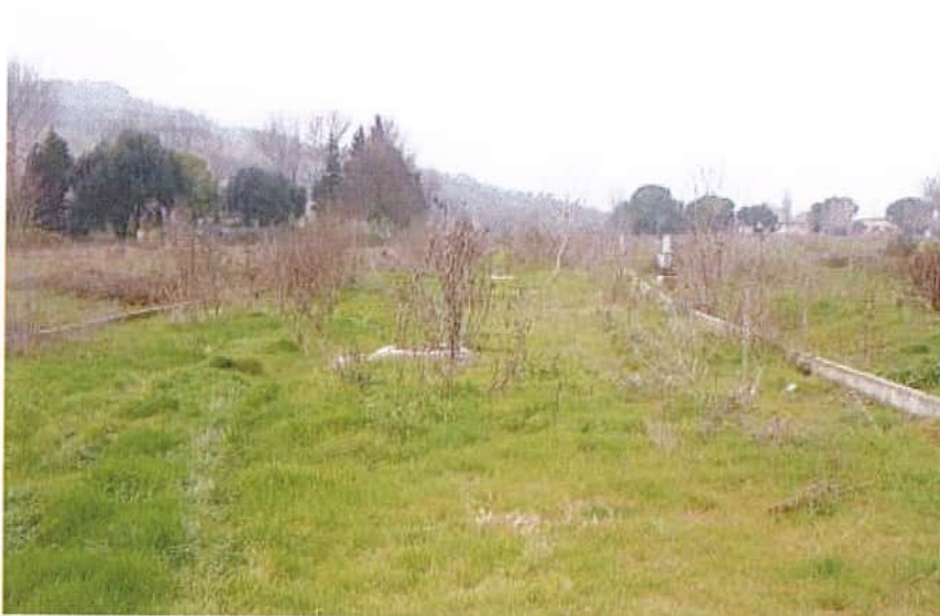
Foto n. 20 - tratto della Via S. Pertini non ultimato
