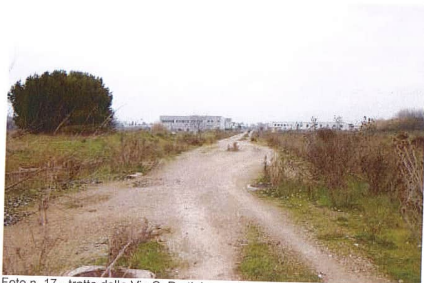
Foto n. 17 - tratto della Via S. Pertini non ultimato
