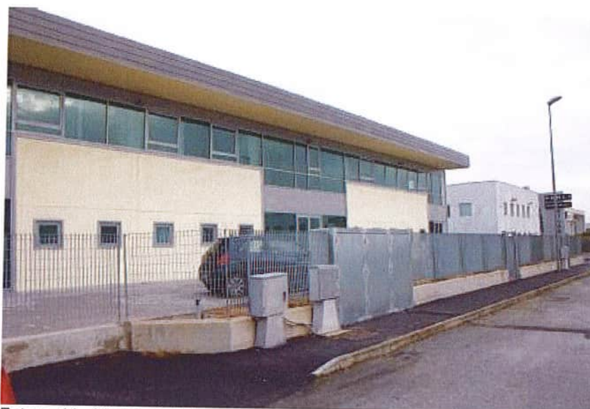
Foto n. 11 - Via S. Pertini
