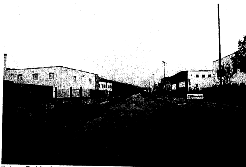
Foto n. 7 - Via S. Pertini
