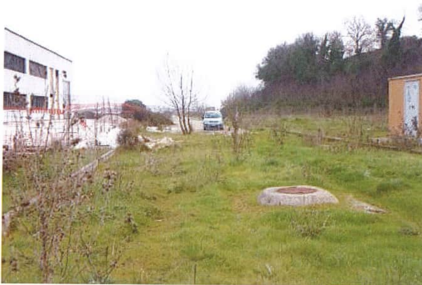
Foto n. 19 - tratto della Via S. Pertini non ultimato
