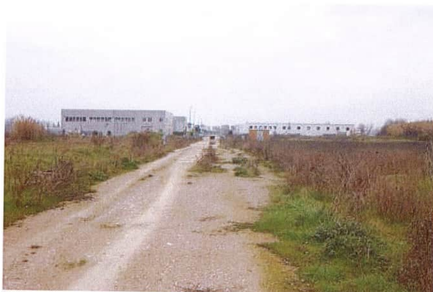
Foto n. 14 - tratto della Via S. Pertini non ultimato
