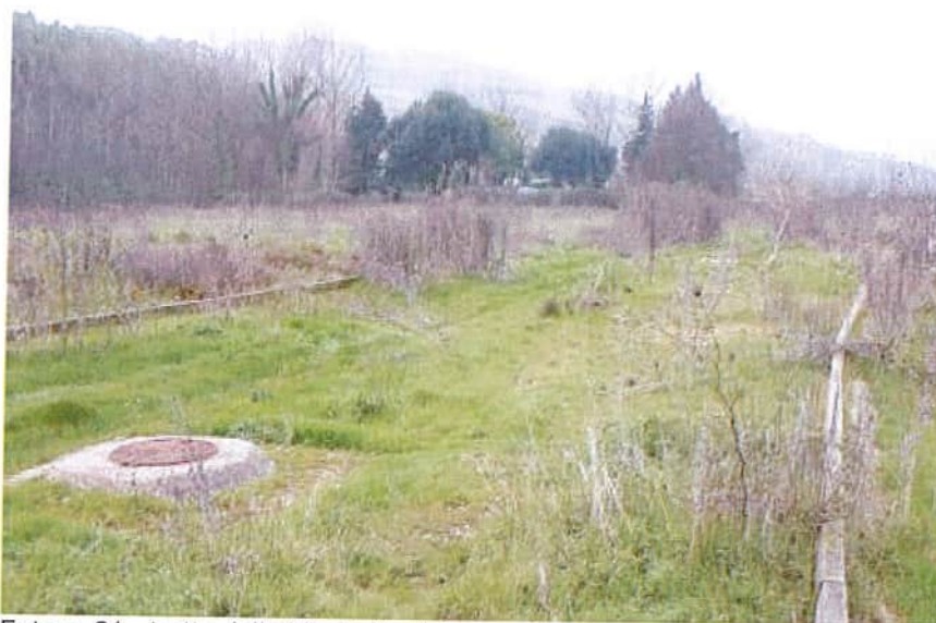
Foto n. 21 - tratto della Via S. Pertini non ultimato
