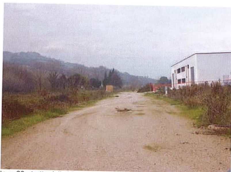
Foto n. 26 - tratto della Via S. Pertini non ultimato
