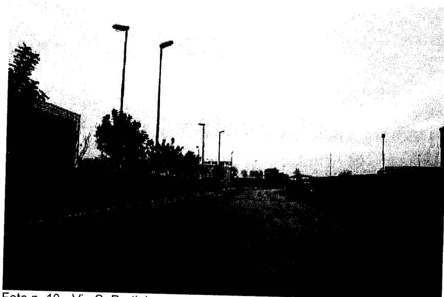
Foto n. 10 - Via S. Pertini
