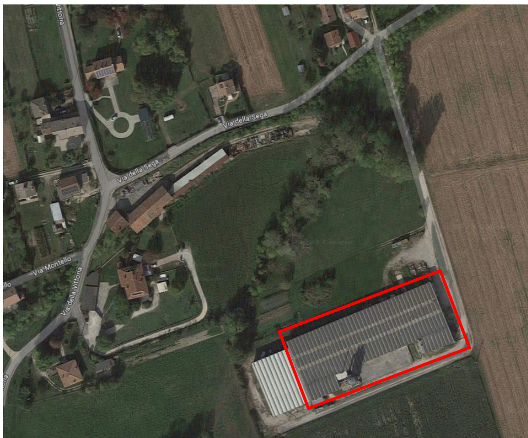
Foto 2 – Ingrandimento area artigianale su zona agricola
